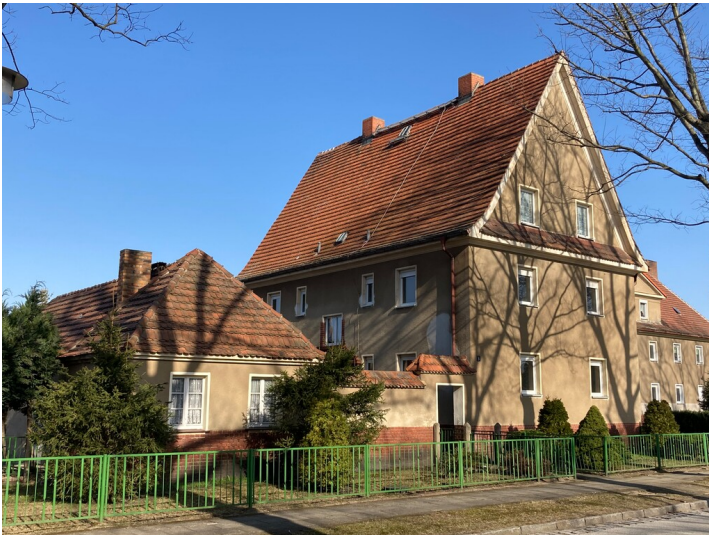
Kolonie Erika, Wohnhäuser Hauptstraße 5; 6; 8, Ansicht von Südosten Fotograf/Urheber: Tom Pfefferkorn
