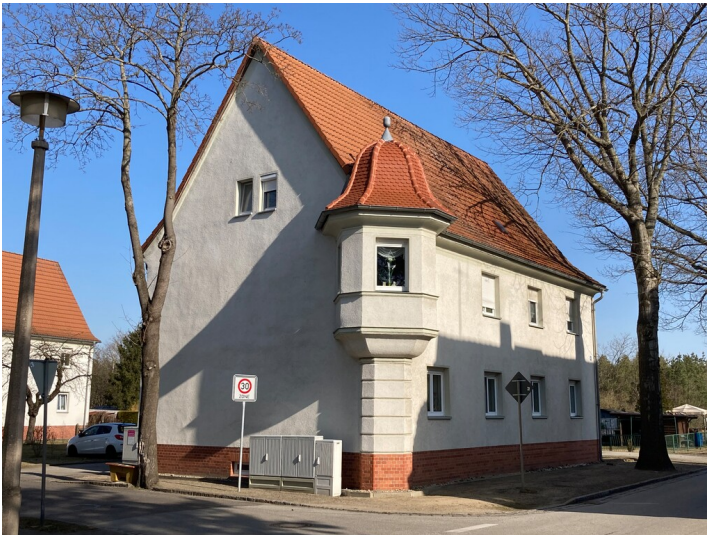
Kolonie Erika, Hauptstraße 4, Ansicht von Süden mit Erker Fotograf/Urheber: Tom Pfefferkorn
