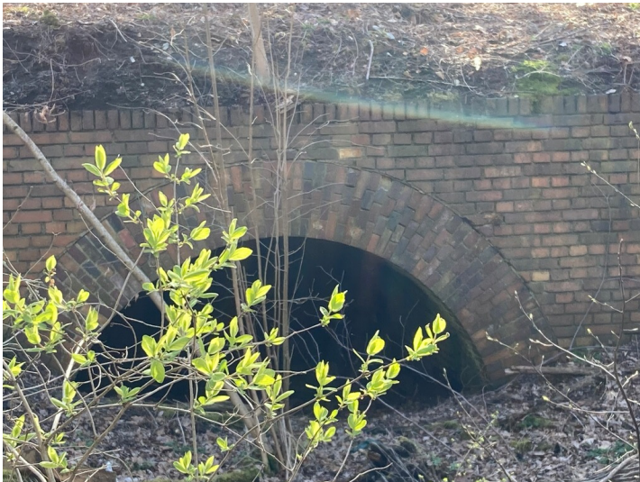
Mehrgleisige Eisenbahnbrücke der ehemaligen Grubenbahnverbindung Laubusch-Trattendorf Kraftwerk Fotograf/Urheber: Tom Pfefferkorn
