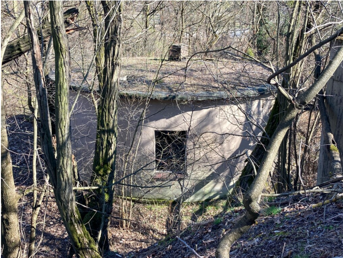
Ehemalige Kläranlage Laubusch, Pumpenhaus Fotograf/Urheber: Tom Pfefferkorn
