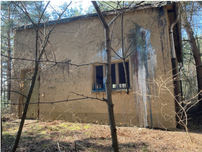
eines der Betriebsgebäude, Ansicht von Norden Fotograf/Urheber: Nora Wiedemann
