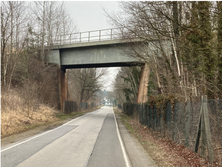
Eingleisige Eisenbahnbrücke mit Widerlagern und Überbau aus Stahlbeton, Bestandteil der Werkbahn des Lautawerks, Ansicht von Westen Fotograf/Urheber: Tom Pfefferkorn
