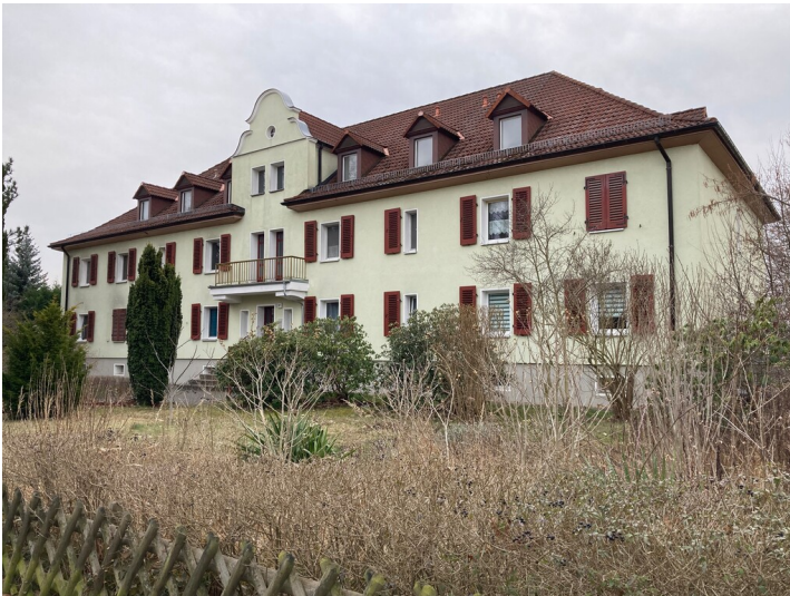
Drei Gemeinschaftshäuser, als Wohnheime für ledige Arbeiter des Lautawerkes errichtet Fotograf/Urheber: Nora Wiedemann
