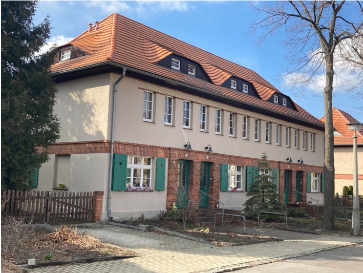
zwei zweigeschossige Mehrfamilienwohnhäuser, hier Nr. 5; 7; 9; 11 von Osten Fotograf/Urheber: Tom Pfefferkorn
