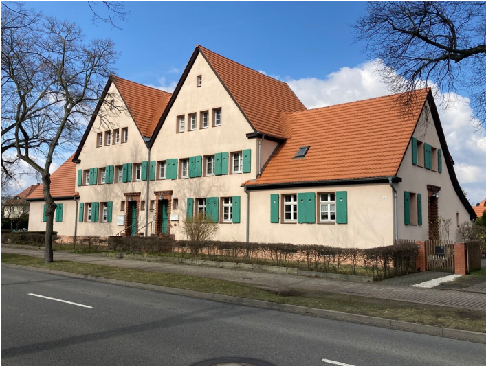
Symmetrisch angelegte Wohnhauszeile Straße der Freundschaft 1-4, Ansicht von Süden Fotograf/Urheber: Tom Pfefferkorn
