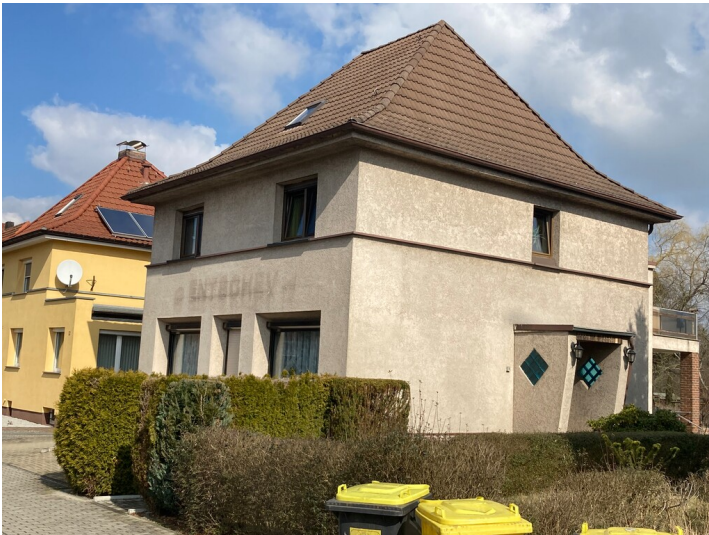
Wohnhäuser sowie Wohn- und Geschäftshäuser auf der Ostseite der Parkstraße, Ansicht von der Parkstraße, hier: Nr. 10 Fotograf/Urheber: Tom Pfefferkorn
