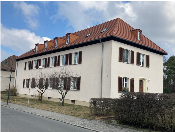
Zweigeschossiges Mehrfamilienwohnhaus Parkstraße 6/8, Ansicht von Südwesten Fotograf/Urheber: Tom Pfefferkorn
