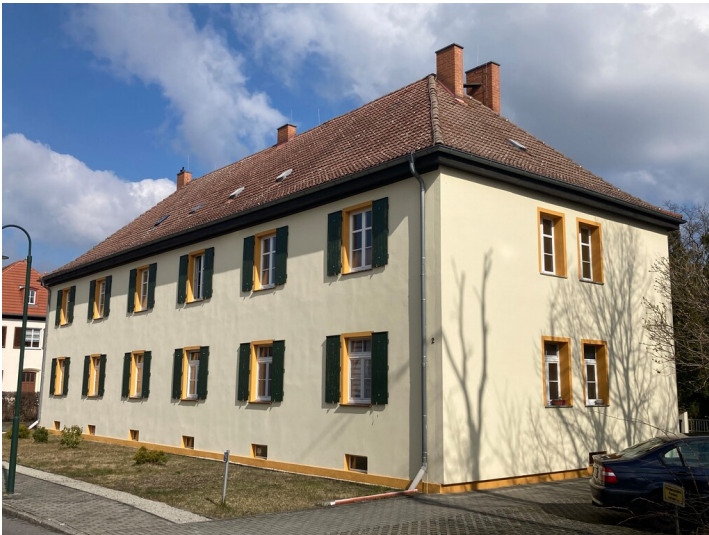
zweigeschossiges Mehrfamilienwohnhaus Parkstraße 2 und 4, Straßenansicht von Südwesten Fotograf/Urheber: Tom Pfefferkorn
