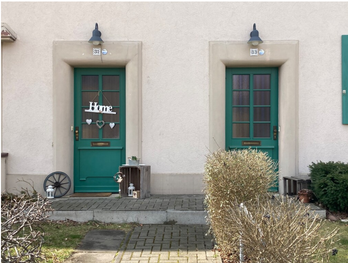
zweigeschossiges Mehrfamilienwohnhaus Parkstraße 27; 29; 31; 33, Eingangsdetail Fotograf/Urheber: Tom Pfefferkorn
