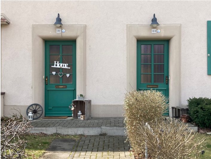
zweigeschossiges Mehrfamilienwohnhaus Parkstraße 27; 29; 31; 33, Eingangsdetail Fotograf/Urheber: Tom Pfefferkorn
