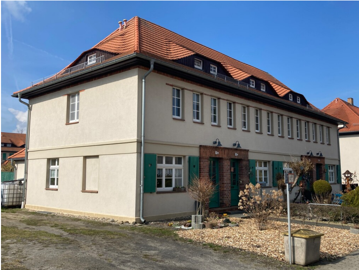
Zweigeschossiges Mehrfamilienwohnhaus Parkstraße 19; 21; 23; 25, Ansicht von Südosten Fotograf/Urheber: Tom Pfefferkorn
