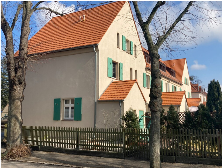
Arbeiter-Mehrfamilienwohnhaus, hofseitige Anbauten, Foto von Südwesten Fotograf/Urheber: Tom Pfefferkorn
