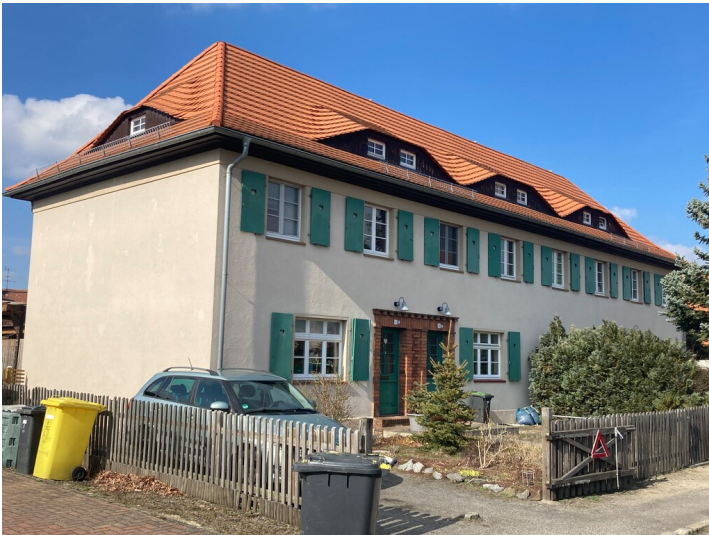
Zweigeschossiges, traufständiges Mehrfamilienwohnhaus, Variation eines Bautyps der Siedlung, Blick von Süden Fotograf/Urheber: Tom Pfefferkorn
