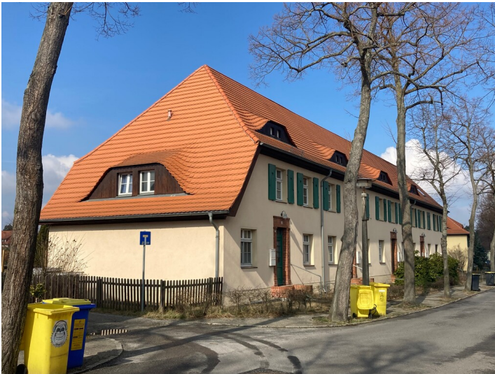
zweigeschossiges, traufständiges Mehrfamilienwohnhaus mit zwei Nebengebäuden, Ansicht von Südosten Fotograf/Urheber: Tom Pfefferkorn
