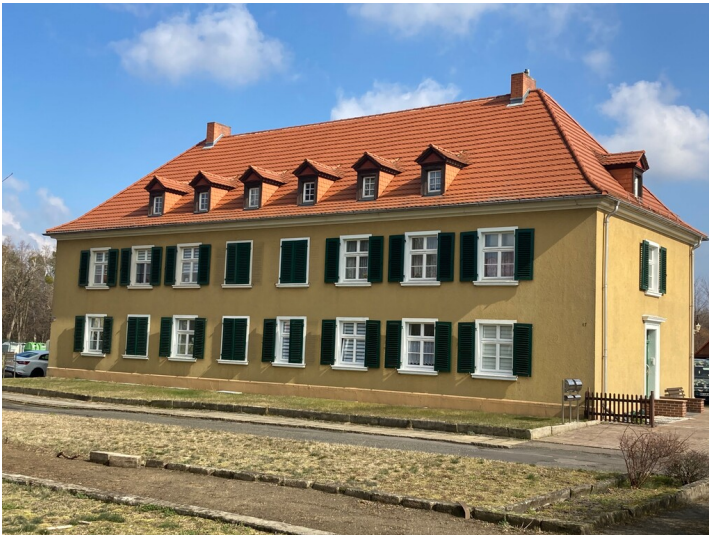
Arbeiterwohnhaus mit zwei Eingängen an den Stirnseiten, Ansicht von Südwesten Fotograf/Urheber: Tom Pfefferkorn
