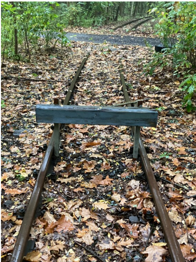
Trasse der 900 mm-spurigen Kohleverbindungsbahn, Strecke Knappenrode-Zeißholz, letzter Bestand an originalen Gleisen südlich von Knappenrode Fotograf/Urheber: Tom Pfefferkorn
