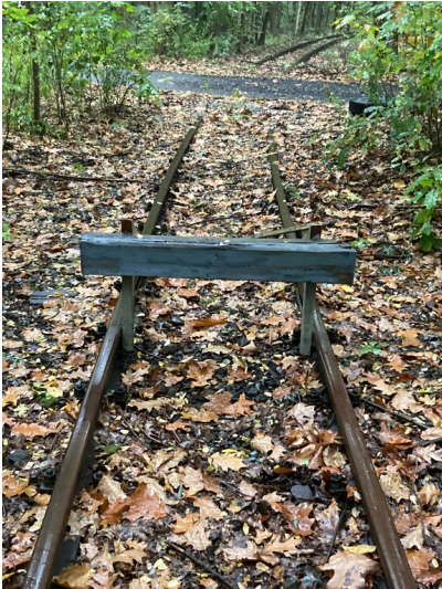
Trasse der 900 mm-spurigen Kohleverbindungsbahn, Strecke Knappenrode-Zeißholz, letzter Bestand an originalen Gleisen südlich von Knappenrode Fotograf/Urheber: Tom Pfefferkorn
