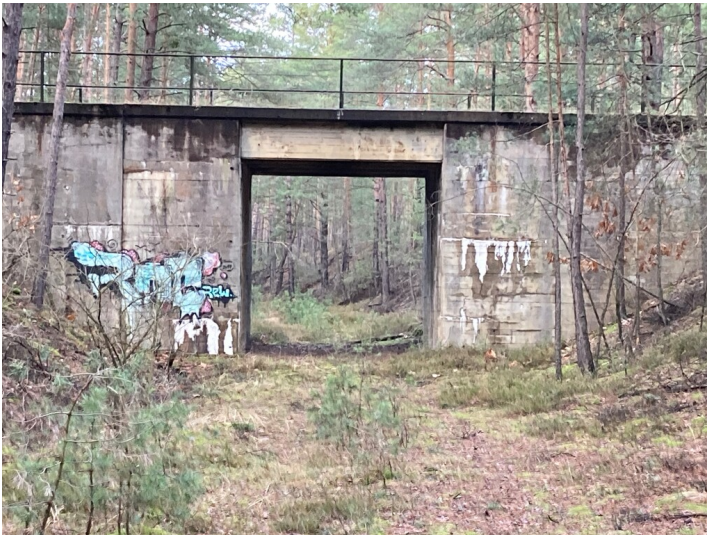
Damm der 900 mm-spurigen früheren Kohlebahn der »Eintracht Braunkohlenwerke und Brikettfabrik A.G.«, Strecke Welzow-Bluno-Knappenrode, Brücke nördlich von Knappenrode Fotograf/Urheber: Tom Pfefferkorn
