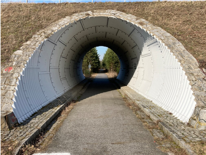
Damm der 900 mm-spurigen Kohlebahn der »Ilse Bergbau-A.G.«, Strecke Laubusch-Scado, später bis Bluno, am »Brandenburger Tor«, Blickrichtung Norden. Hier befand sich bis 2002 eine dreigleisige Werkbahnunterquerung der Straße. Fotograf/Urheber: Tom Pfefferkorn
