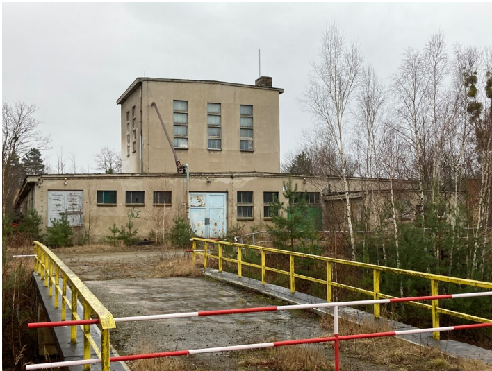
Wasserwerk "Brandenburger Tor", Ansicht von Norden Fotograf/Urheber: Tom Pfefferkorn
