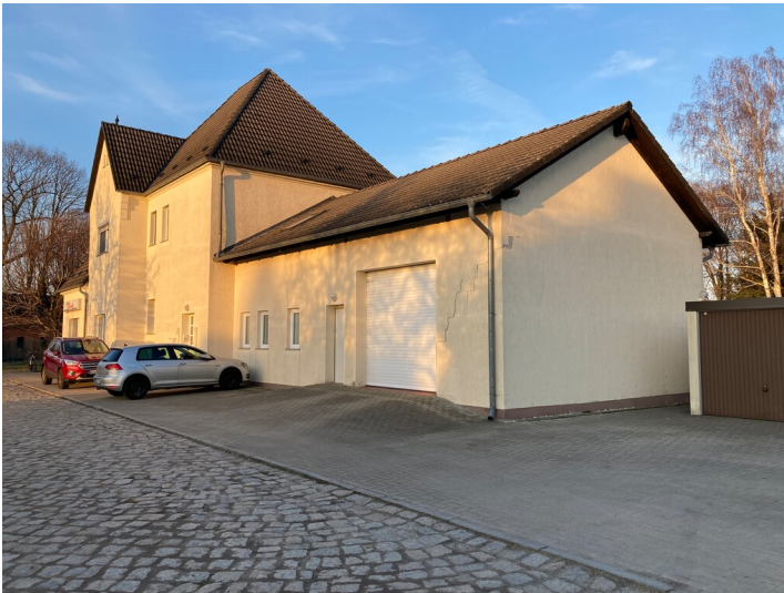
Einfaches Bahnhofsgebäude der ehemaligen, ursprünglich zu den Preußischen Staatseisenbahnen gehörenden Bahnstrecke 6597 Neupetershain-Hoyerswerda, Ansicht von Südwesten Fotograf/Urheber: Tom Pfefferkorn
