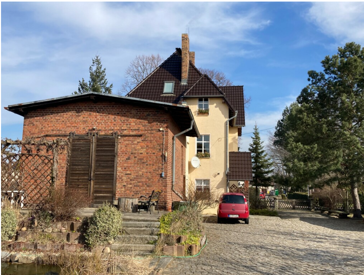
Bahnhof Bergen der ehemaligen, ursprünglich zu den Preußischen Staatseisenbahnen gehörenden Bahnstrecke 6597 Neupetershain-Hoyerswerda, von Süden Fotograf/Urheber: Tom Pfefferkorn
