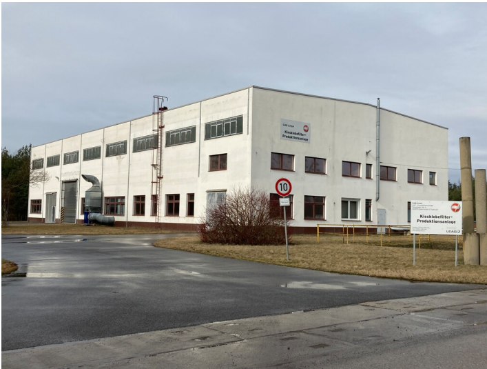
Werkhalle wohl Fertigteilbau EMZG 83, 6m-Raster, von Südosten Fotograf/Urheber: Tom Pfefferkorn
