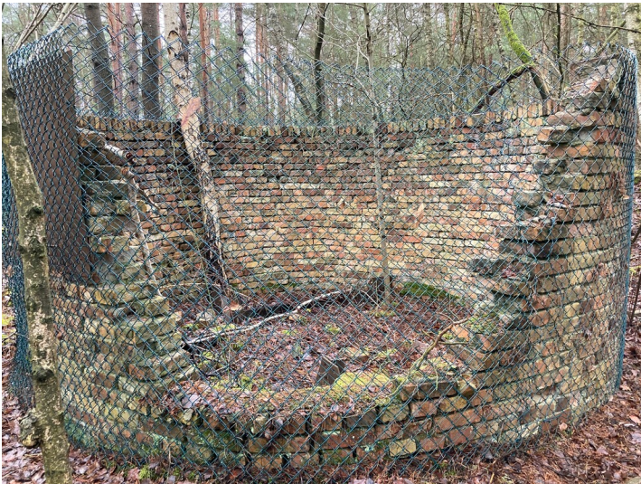
Ehemalige Tagesanlagen der Grube "Alice" Pechern, Reste des gemauerten Schachtes Fotograf/Urheber: Tom Pfefferkorn
