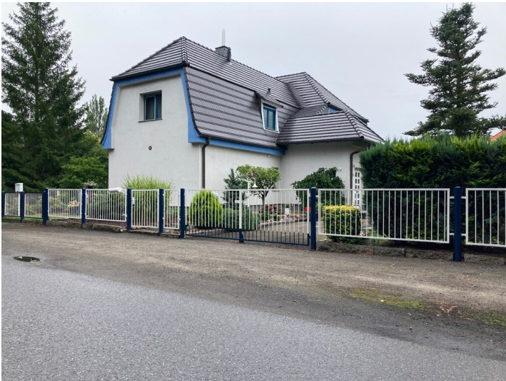
Einfamilienwohnhaus Lohsaer Weg 1, Ansicht von Norden Fotograf/Urheber: Tom Pfefferkorn
