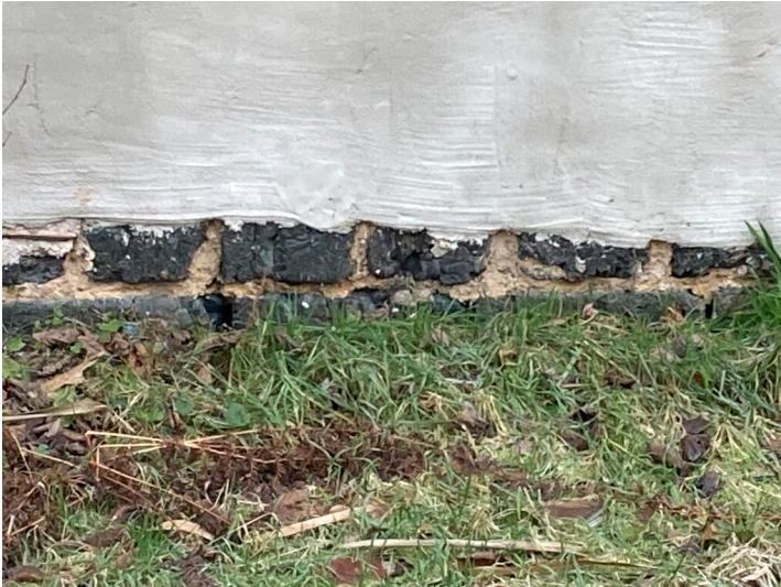
Betriebsgebäude des ehem. Dampfsägewerkes, heute als Baugeschäft genutzt, Detail Glasschlackesteine im Fundament Fotograf/Urheber: Tom Pfefferkorn
