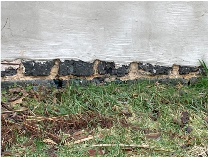
Betriebsgebäude des ehem. Dampfsägewerkes, heute als Baugeschäft genutzt, Detail Glasschlackesteine im Fundament Fotograf/Urheber: Tom Pfefferkorn
