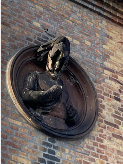
Wasserturm des ehem. Steinzeugwerkes, Fassadendetail Terrakotte Fotograf/Urheber: Tom Pfefferkorn
