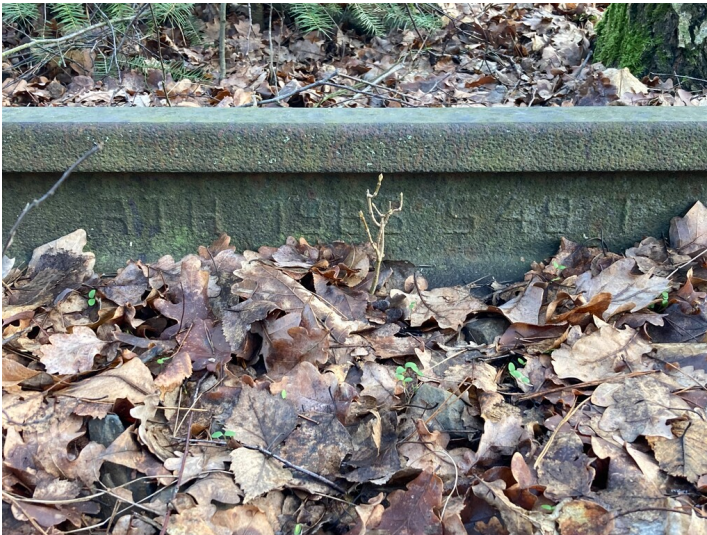
Anschlussgleis, ca. 1,5 km lang, vollständig erhaltener Bahndamm mit Oberbau, Walzzeichen Fotograf/Urheber: Tom Pfefferkorn
