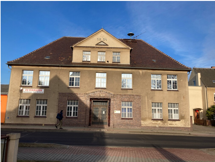
Deutsche Ton- und Steinzeugwerke, Verwaltung, Straßenansicht Fotograf/Urheber: Kathrin Krüner
