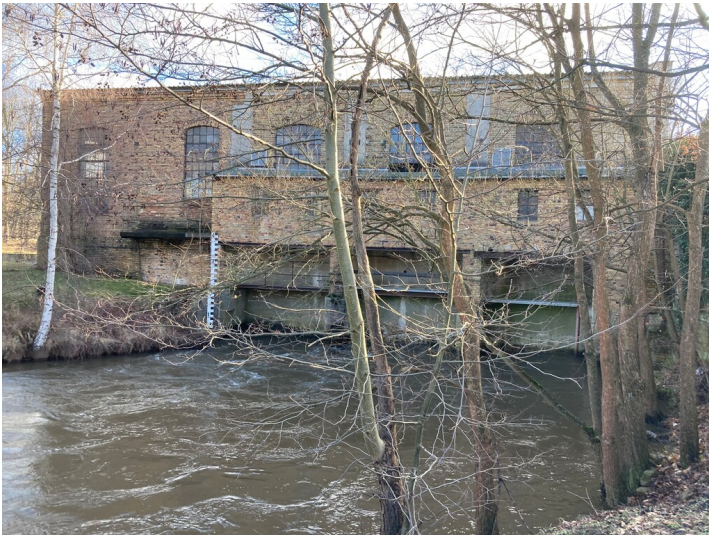
Turbinenhaus der Wasserkraftanlage mit dem Neißewehr als letzter baulicher Anlagenteil der ehemaligen Papierfabrik von Arnim, Ansicht von Nordwesten Fotograf/Urheber: Tom Pfefferkorn
