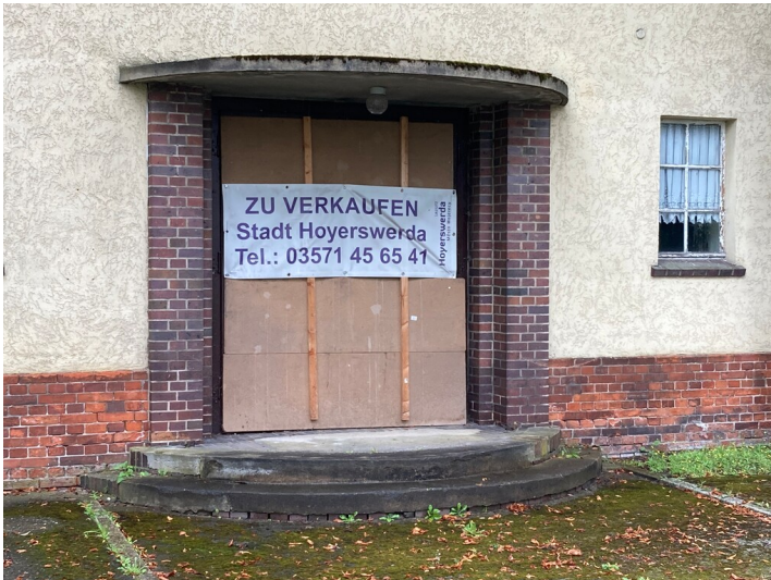
Eingang mit Klinkerrahmung Fotograf/Urheber: Tom Pfefferkorn
