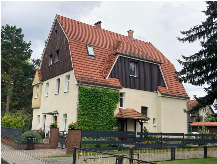
Friseurhaus* Ernst-Thälmann-Straße 3, Ansicht vom August-Bebel-Platz Fotograf/Urheber: Tom Pfefferkorn
