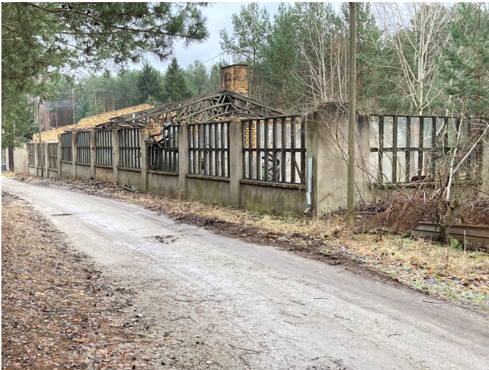
Gebäude der Tagesanlagen Braunkohlengrube Caroline II, Hallen Drachenbergweg 6 Fotograf/Urheber: Tom Pfefferkorn
