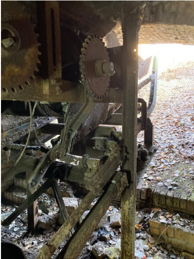
Relikte der Verladeanlage der 900 mm-spurigen Kohlebahn Grube Adolf - Brikettfabrik Weißwasser. Umlenkmechanismus und Vorbrecheinrichtung Fotograf/Urheber: Tom Pfefferkorn
