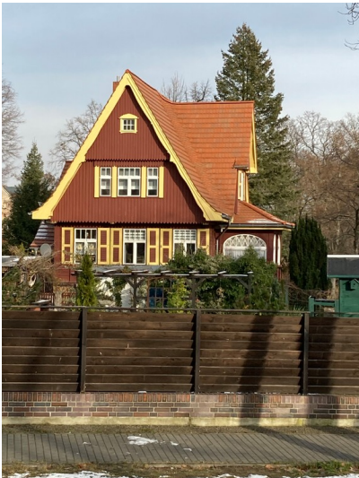
Villa, Holzhaus im Heimatstil, Ansicht von Süden/Rosa-Luxemburg-Straße Fotograf/Urheber: Tom Pfefferkorn
