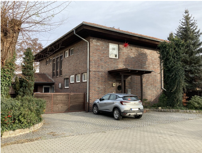
Wohnhaus in offener Bebauung und Einfriedung Fotograf/Urheber: Tom Pfefferkorn
