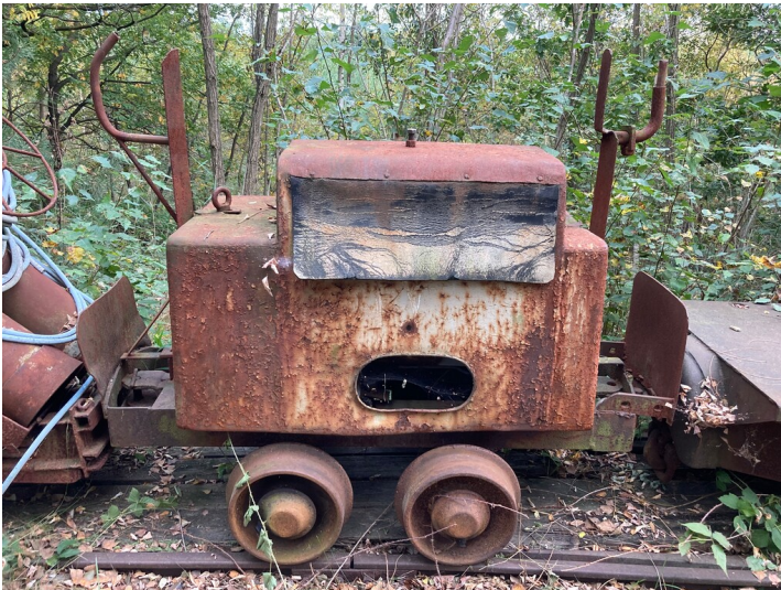
Spezialwagen, wohl für Transformator und zum Aufwickeln von Kabeln/ zum Anschluss des Kompressors/ der Hydraulikpumpe (31000063) Fotograf/Urheber: Tom Pfefferkorn
