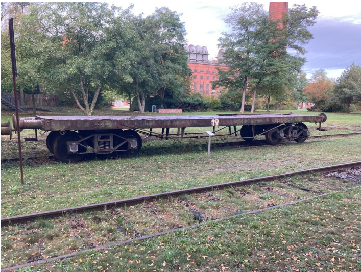
Brikettfabrik Werminghoff/ Knappenrode, Flachwagen 19, genietete Konstruktion mit vier durchlaufenden Längsträgern Fotograf/Urheber: Tom Pfefferkorn
