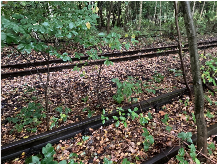
Brikettfabrik Werminghoff/ Knappenrode, Gleisanlagen 900 mm der ehemaligen Kohleverbindungsbahn nach Zeißholz Fotograf/Urheber: Tom Pfefferkorn
