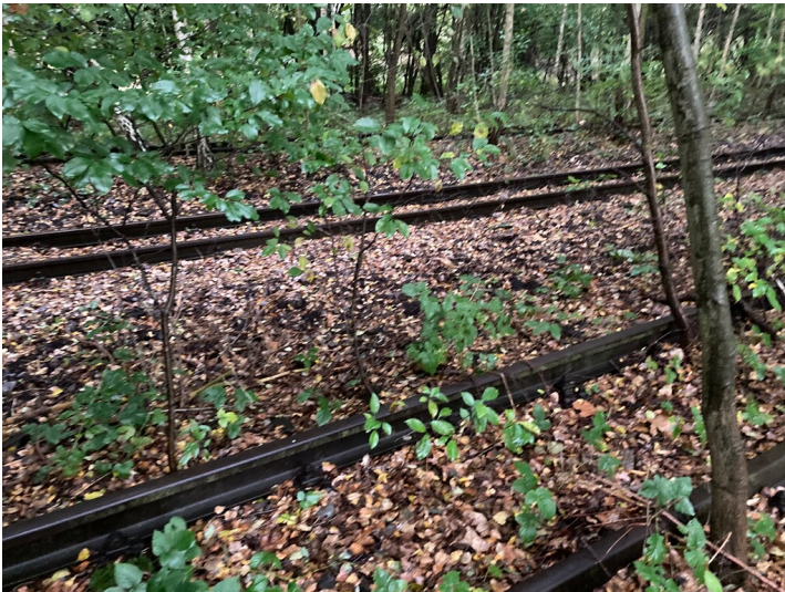
Brikettfabrik Werminghoff/ Knappenrode, Gleisanlagen 900 mm der ehemaligen Kohleverbindungsbahn nach Zeißholz Fotograf/Urheber: Tom Pfefferkorn
