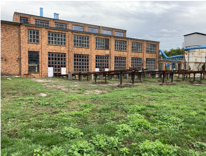
Brikettfabrik Werminghoff/ Knappenrode, Fabrik V, Westansicht Fotograf/Urheber: Nora Wiedemann
