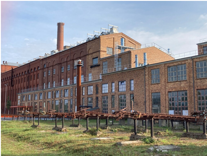
Brikettfabrik Werminghoff/ Knappenrode, Fabrik IV, Ansicht von Südwesten Fotograf/Urheber: Kathrin Krüner
