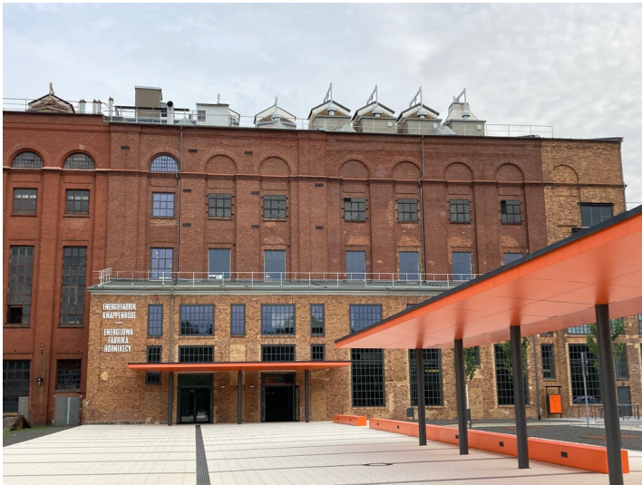
Brikettfabrik Werminghoff/ Knappenrode, Fabrik III, Ansicht von Westen Fotograf/Urheber: Kathrin Krüner
