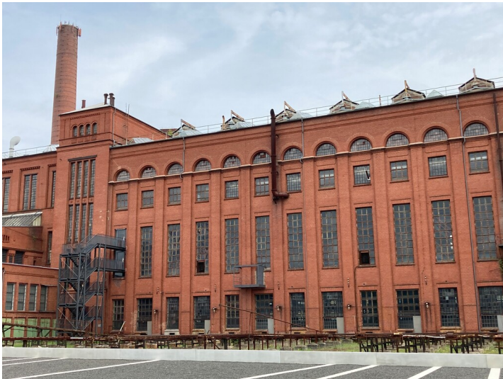
Brikettfabrik Werminghoff/ Knappenrode, Fabrik I, Westansicht Fotograf/Urheber: Kathrin Krüner
