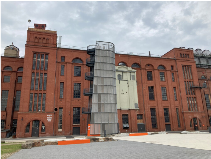
Brikettfabrik Knappenrode, Nassdienstgebäude, Ostansicht Fotograf/Urheber: Anja Prust
