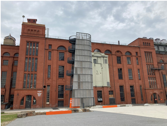
Brikettfabrik Knappenrode, Nassdienstgebäude, Ostansicht Fotograf/Urheber: Anja Prust
