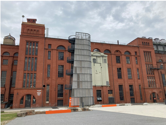
Brikettfabrik Knappenrode, Nassdienstgebäude, Ostansicht Fotograf/Urheber: Anja Prust
