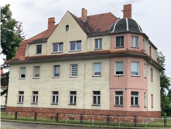
Mehrfamilienwohnhaus "Steigerhaus", Ernst-Thälmann-Straße 1, Ansicht vom August-Bebel-Platz Fotograf/Urheber: Tom Pfefferkorn
