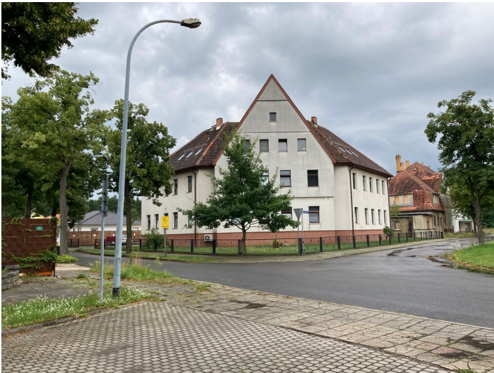
Ansicht von der Straßenkreuzung (Westen) Fotograf/Urheber: Tom Pfefferkorn
