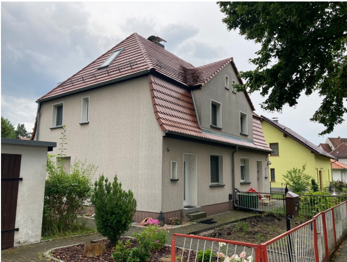
Ansicht von Nordosten Fotograf/Urheber: Tom Pfefferkorn
