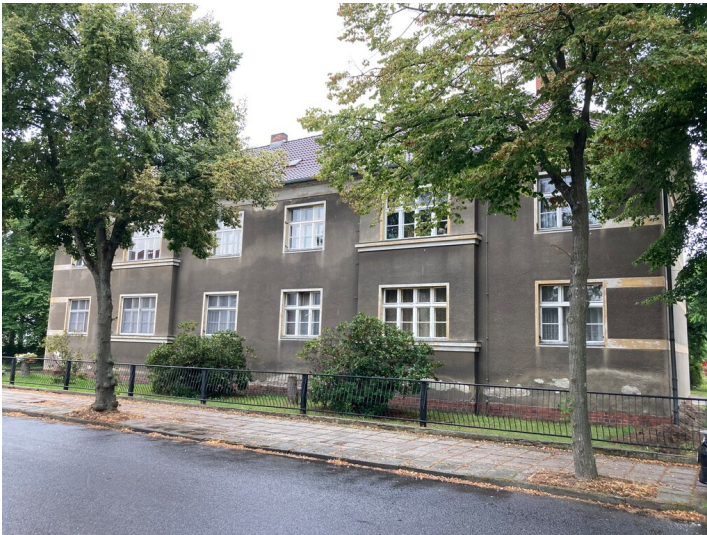
Mehrfamilienwohnhaus Lessingstraße 20, Straßenfassade, in wesentlichen Teilen bauzeitlich überkommen. Wohl Bestandteil der 2. Siedlungserweiterung Fotograf/Urheber: Tom Pfefferkorn
